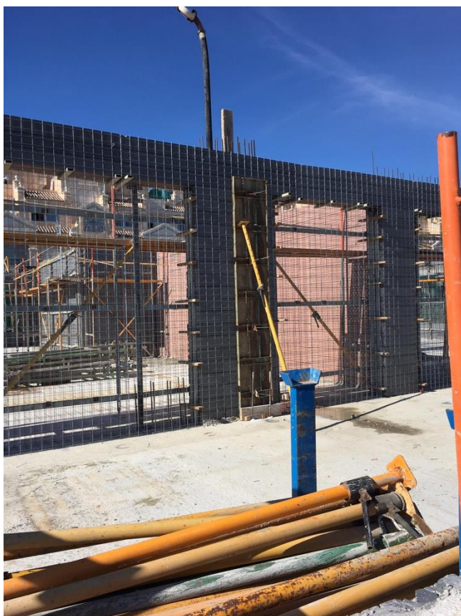
Refuerzo de pilar embebido en muro.
