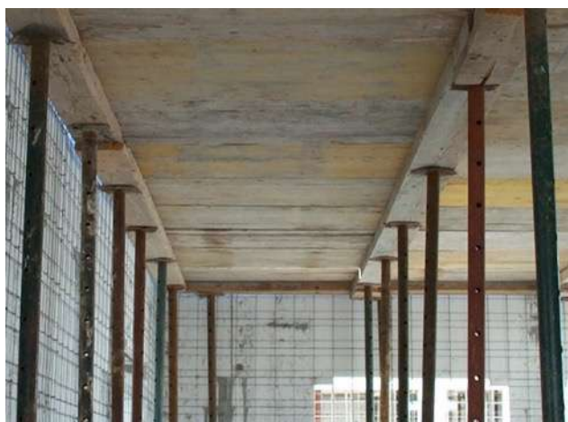
Figura 30 Puntales y tableros para encofrar
